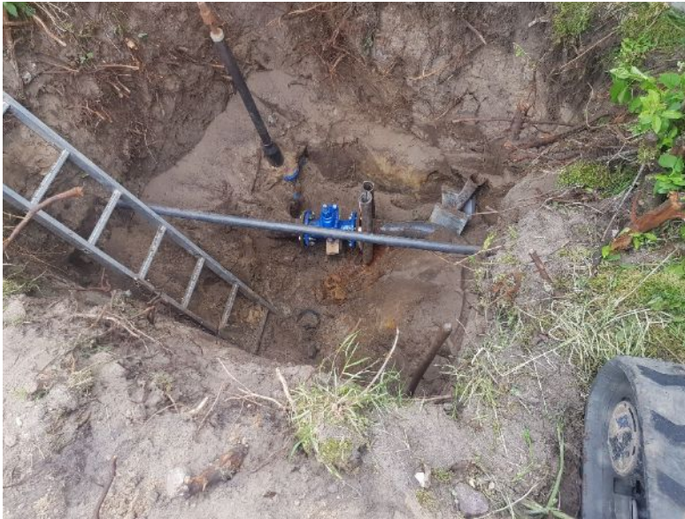
Abb. 3: Neuer Netzschieber im Rumbleker Weg
