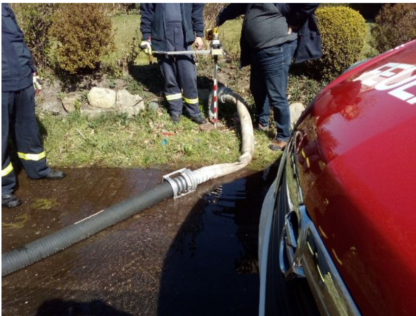
Abb. 4: Spülen des Leitungsnetzes
