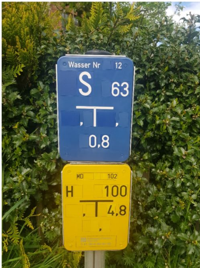
Abb. 2: Netzschieberbeschilderung
