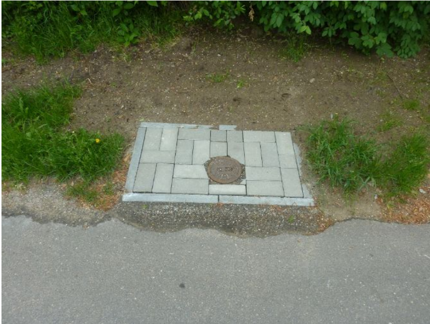
Abb. 1: Pflasterung eines Netzschiebers
